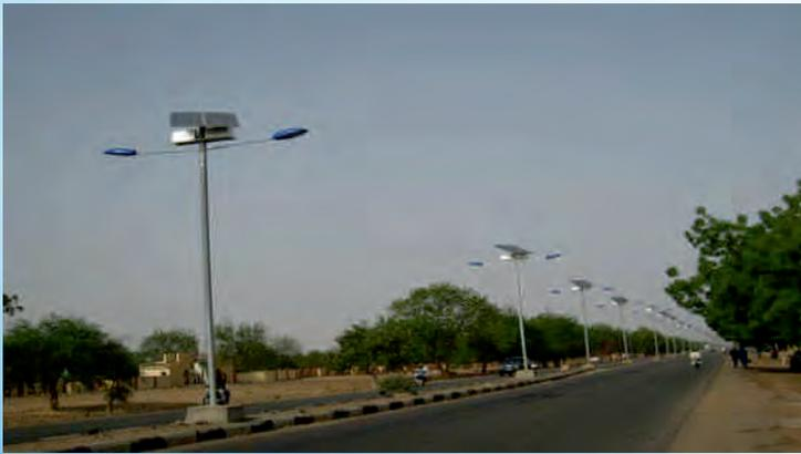
Modèle: BRH-D6 (Coffret Batteries sur mât)
