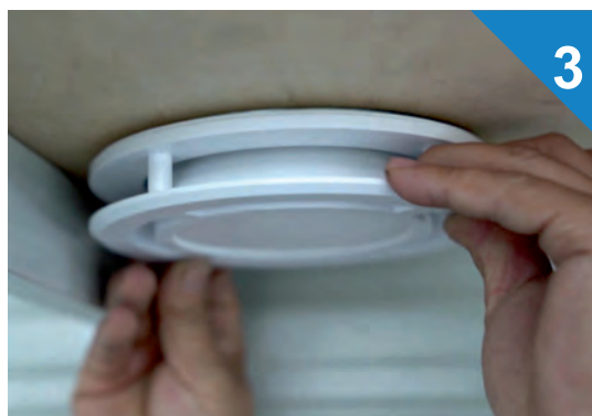
③ Maintenir les ressorts et insérer l'appareil dans le trou du plafond
